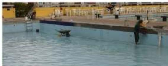
Substituição de azulejos quebrados e troca por pastilhas
