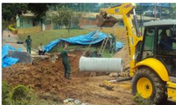
13/01/2012 Cessam as chuvas e a equipe de manutenção entra em ação.
