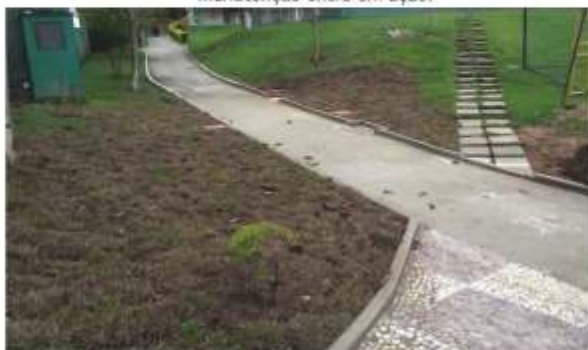
29/01/2012 Obra pronta como se nada houvesse acontecido
